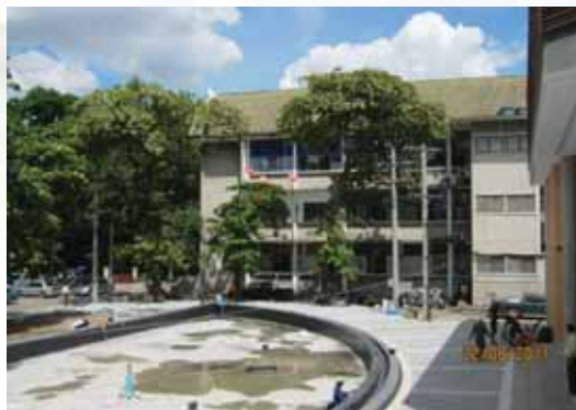
ภาพแสดงอาคารตำรวจป่าไม้ ด้านหน้าอาคารฝั่งขวา
