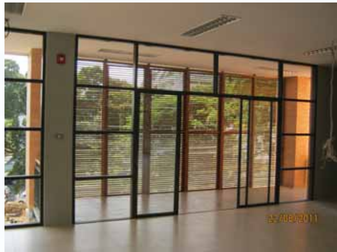
ภาพแผงไม้บังแดดชั้น 2 ห้องทำงานสำนักงาน (ด้านทิศตะวันตก)
